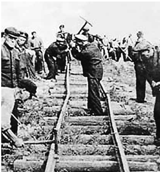
Строительство железной дороги Александров Гай – Эмба
