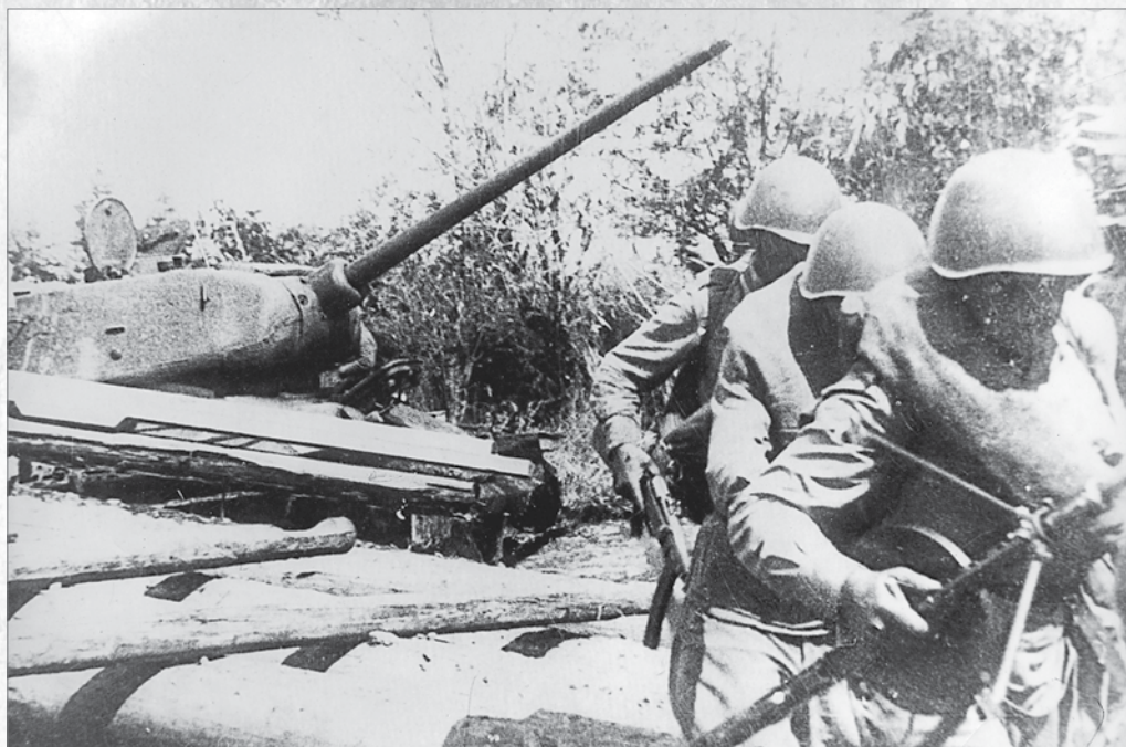
Переправа воинского подразделения через реку по разрушенному мосту. Харамитогский укрепрайон
