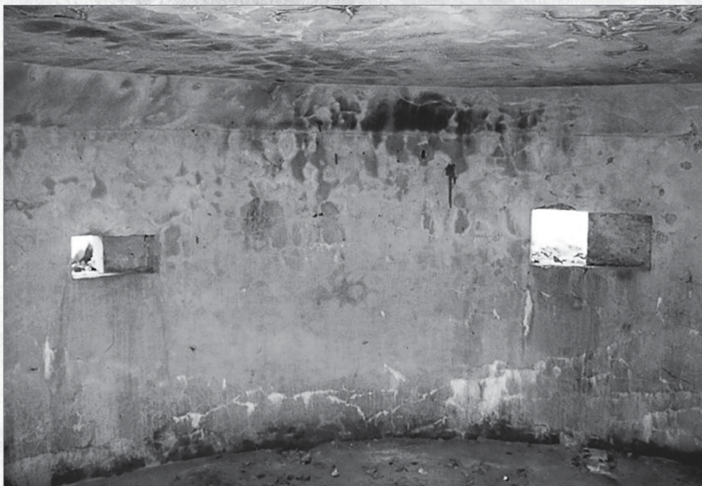
Внутренний вид блокгауза
